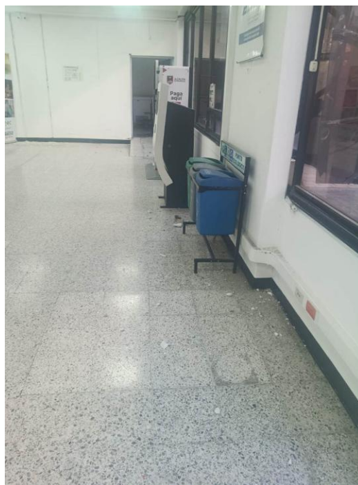
Fotografía 6. Abertura de cielo y exposición de instalaciones; fisuración en cerramiento.
