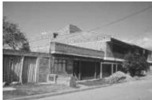
Fotografía. Edificación construida en mampostería
