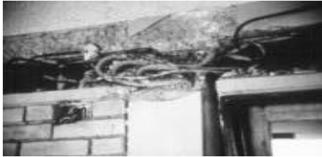
Fotografías. Niveles de daño en elementos de concreto reforzado.
