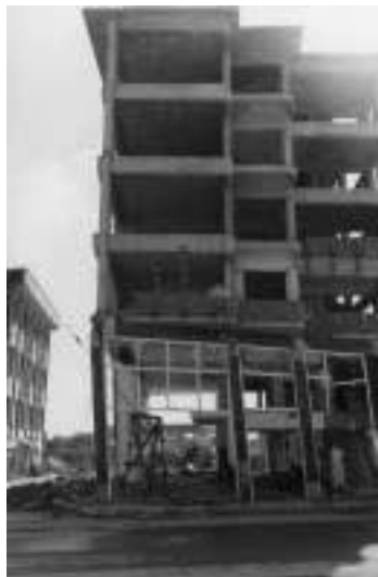
Fotografías. Inclinación de la edificación o de un entresijo
