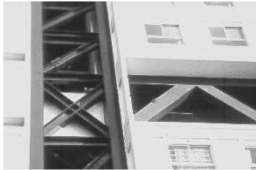
Fotografía. Edificación construida en acero
