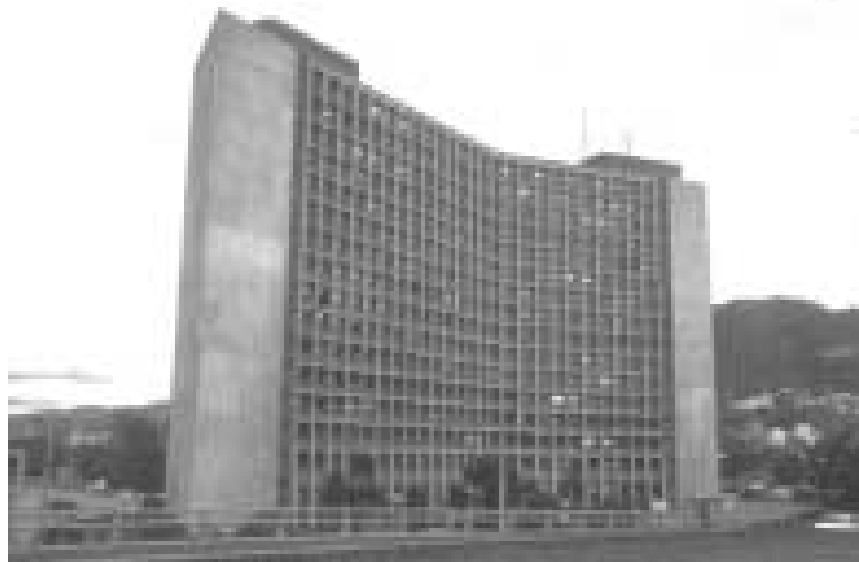
Fotografía. Edificación construida en pórticos en concreto reforzado
