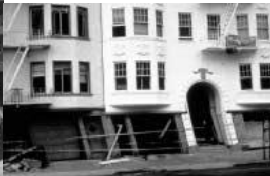
Fotografías. Inclinación de la edificación o de un entresijo
