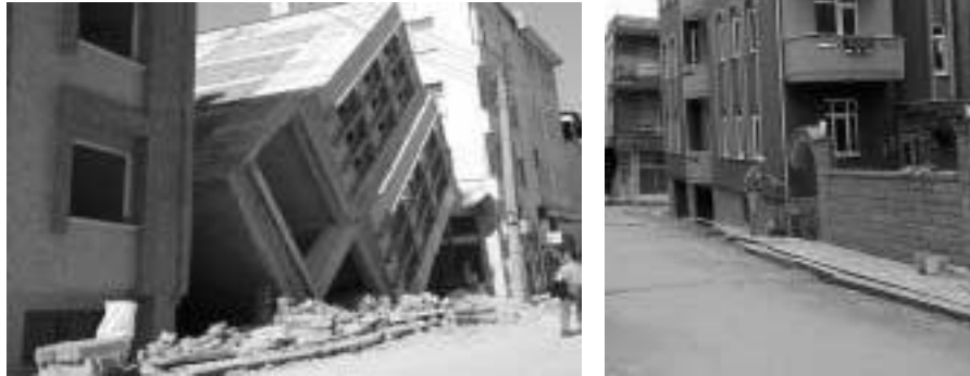
Fotografías. Fallas en el suelo de cimentación
