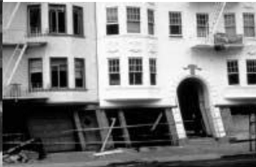
Fotografías. Inclinación de la edificación o de un entresijo
