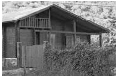
Fotografía. Edificación construida en madera
