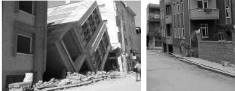
Fotografías. Fallas en el suelo de cimentación
