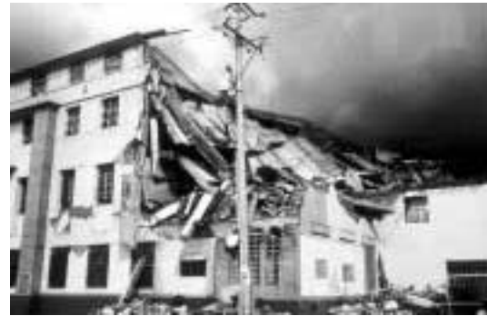
Fotografías. Colapso total y parcial de edificaciones
