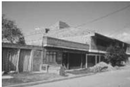
Fotografía. Edificación construida en mampostería
